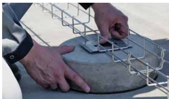
Potentialutjämnning av ramverk där man upprätthåller skiljeavstånd, eller anläggning utan åkskydd.
